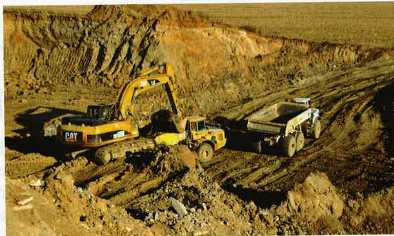
Aménagement des terres inertes sur le site du parc de l'écoquartier Arboretum de Chanteloup, à Moissy-Cramayel (Seine-et-Marne).
