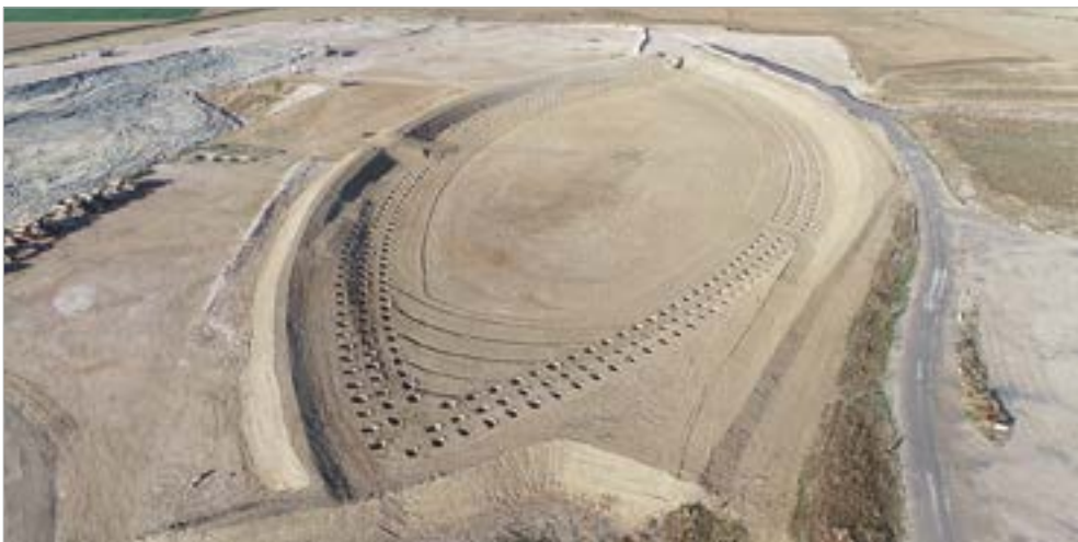
Septembre 2022 | Terrassement des fosses d'arbres et nappage de terre végétale.
