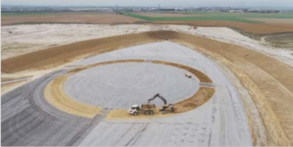
Octobre 2022 | Traitement de la sous-couche de limon.
