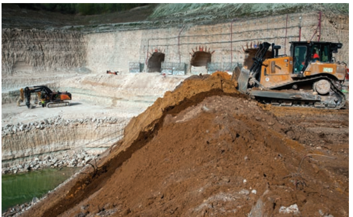
Opérations de remblaiement pour Placo/Saint Gobain en Île-de-France.
