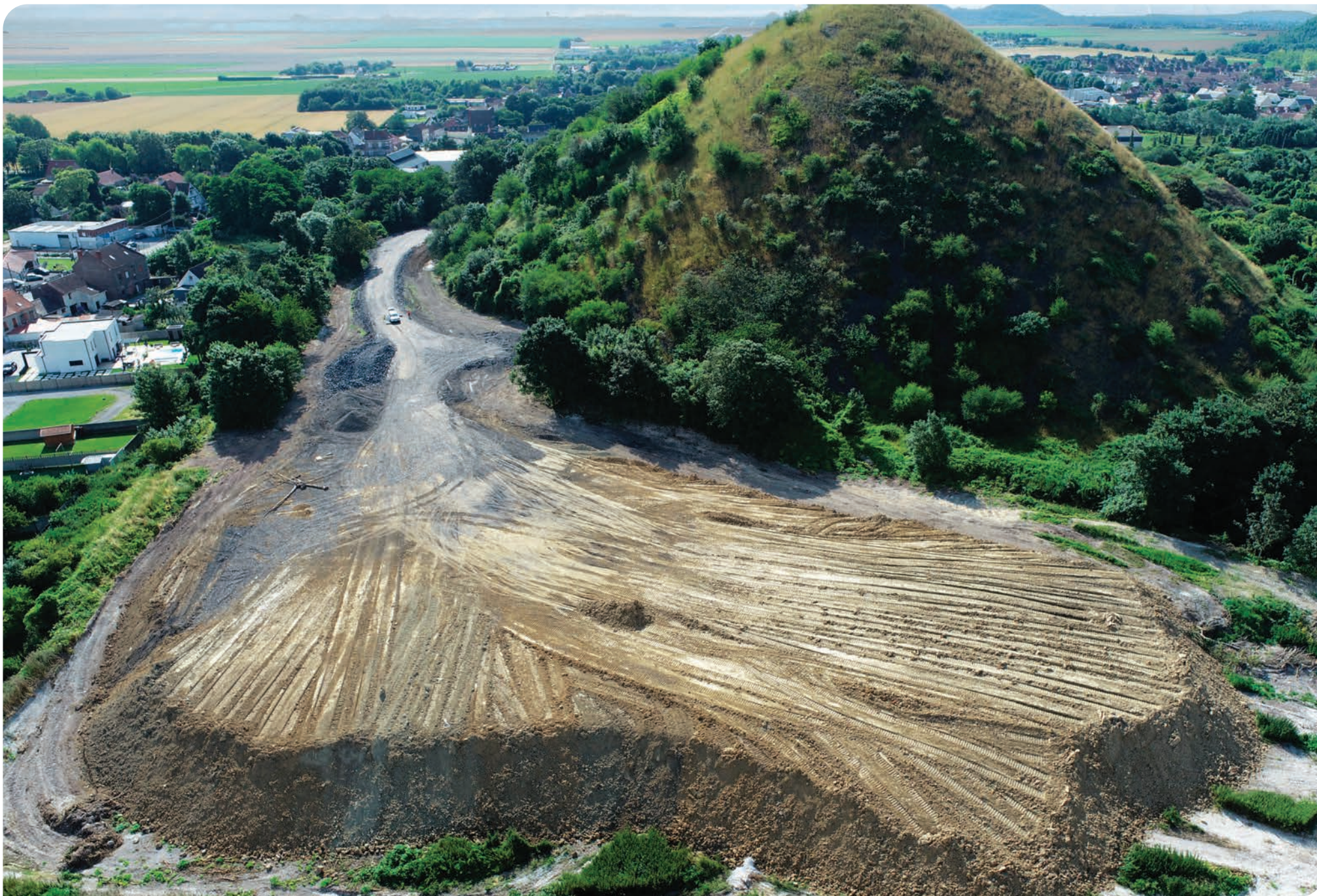
Apports de terres inertes pour la réalisation du belvédère et l'éradication des Berces du Caucase. – Mars 2025
