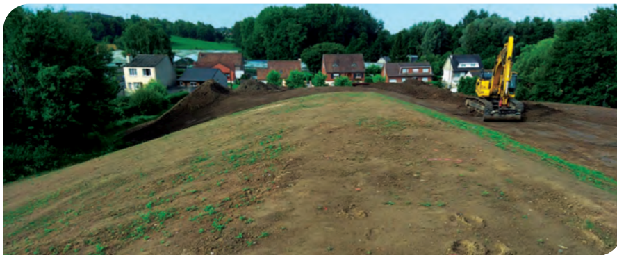
Mai 2024, apport de terres des chantiers locaux et travaux de terrassement des modelés
