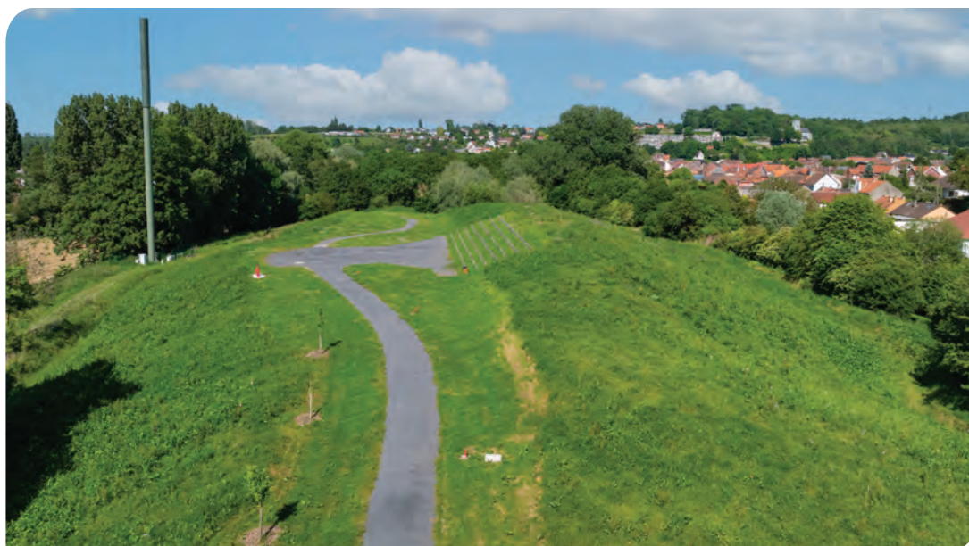
Aménagement du site finalisé
